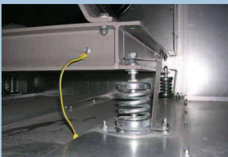
Rama wentylatora na wibroizolatorach z zabezpieczeniem transportowym
